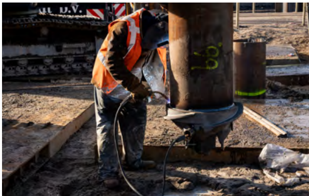
Funderingspalen voor de ongelijkvloerse kruisingen worden ingebracht en ondertussen rijdt de tram gewoon door.
