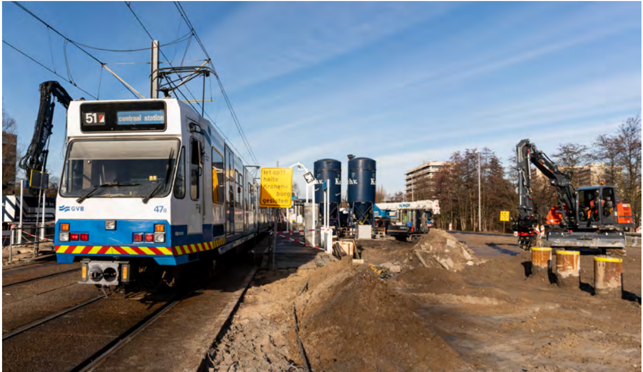
Funderingspalen voor de ongelijkvloerse kruisingen worden ingebracht en ondertussen rijdt de tram gewoon door.
