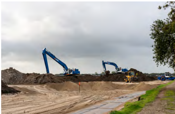
Er wordt zo'n 80.000 kuub zand aangebracht op het opstelterrain.
