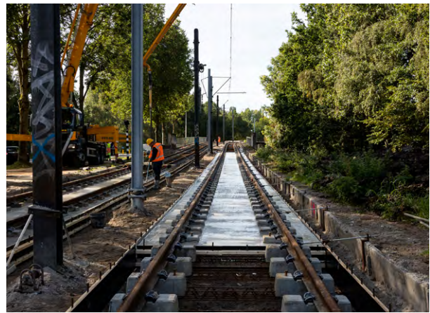
Aanleg grasbaan bij halte Meent.
