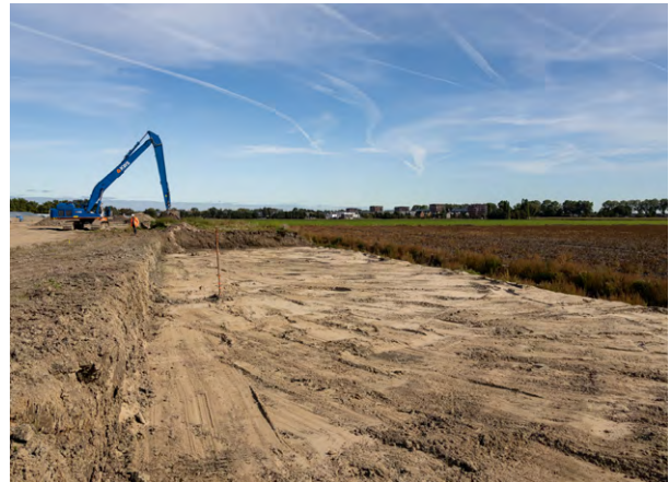
Grond wordt op het opstelterrein verwijderd dat als voorbelasting heeft gediend
