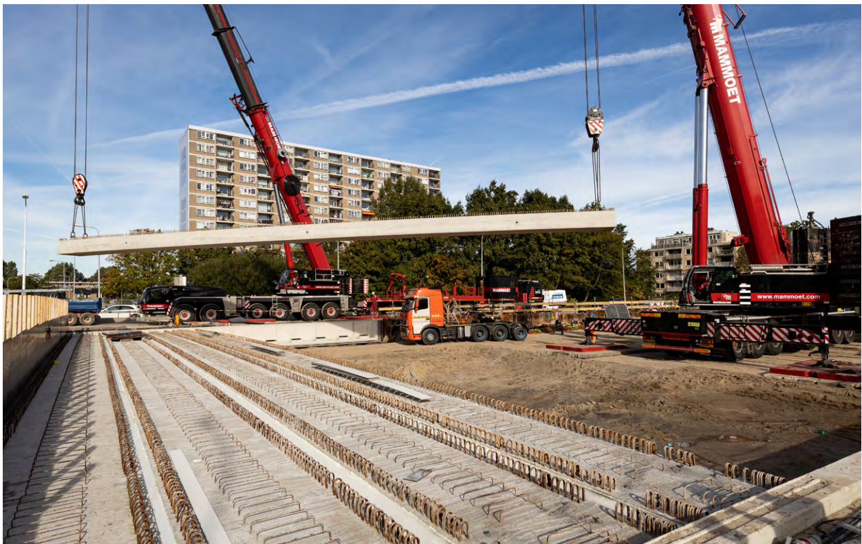
Betonnen liggers worden op het noordelijk wegdek bij de Sportlaan geplaatst.
