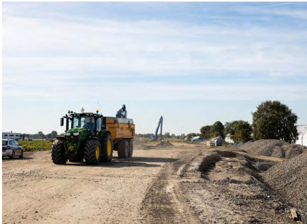
Grond wordt op het opstelterrein verwijderd dat als voorbelasting heeft gediend
