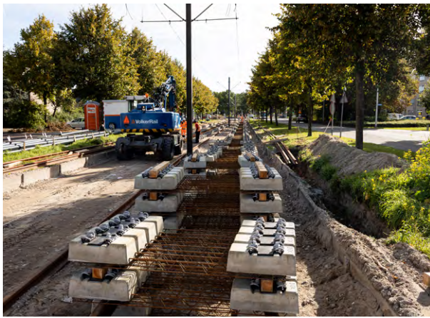
De nieuwe halte Brink wordt opgebouwd.
