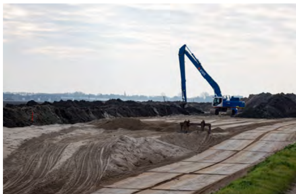
Er wordt zo'n 80.000 kuub zand aangebracht op het opstelterrain.
