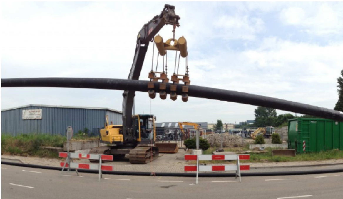
Voorbeeld van werkzaamheden in uitvoering
