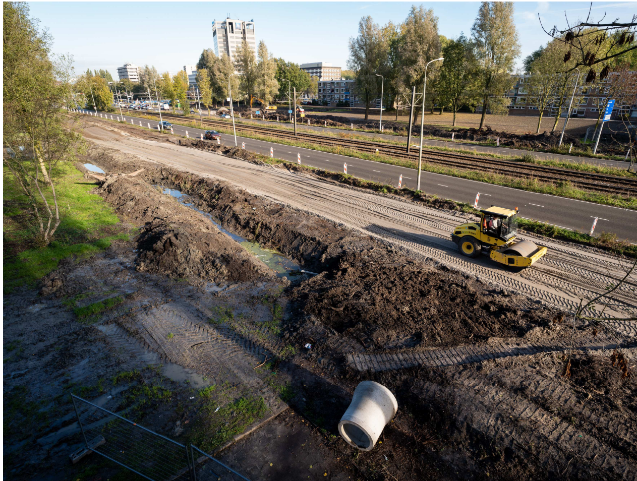
Aanleggen tijdelijke Beneluxbaan
